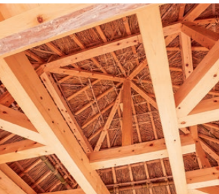
木材は寄付、市内の建設会社と大内宿の屋根葺き職人の皆さんの協力で完成した東屋。伝統工法による木組み、職人の手で切り揃えられたかやぶき屋根の美しい軒は見事
