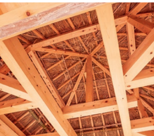
木材は寄付、市内の建設会社と大内宿の屋根葺き職人の皆さんの協力で完成した東屋。伝統工法による木組み、職人の手で切り揃えられたかやぶき屋根の美しい軒は見事
