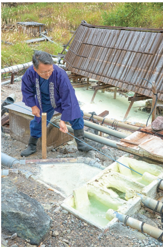
温泉水を引く管の清掃。湯の管理をする湯番などにより付着した湯の花を週に1回、専用の道具で取り除いている。
