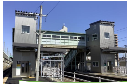
【JR東北本線 南福島駅へエレベーターを設置】
