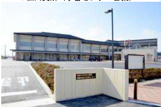
▼松川支所（学習センター合築）
