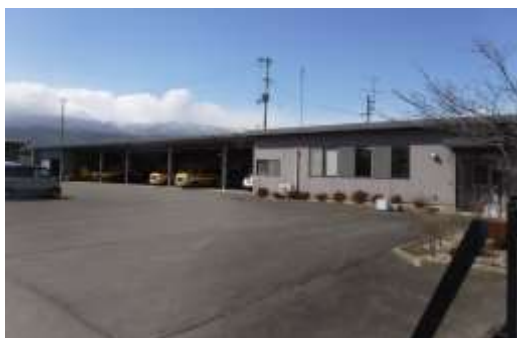
▲維持補修センター
