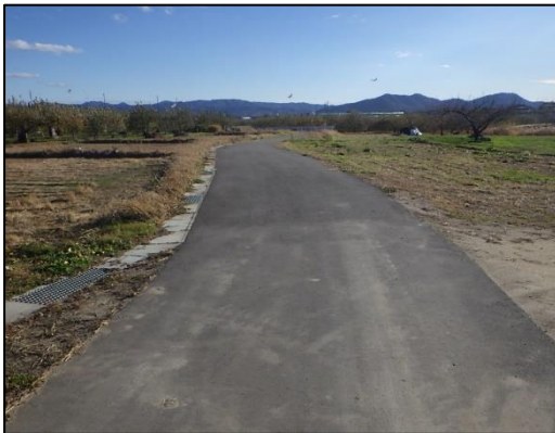
飯坂町湯野地区 農道改良工事
