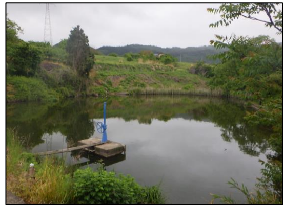
防災重点ため池 (太子沼【飯坂町湯野】)
