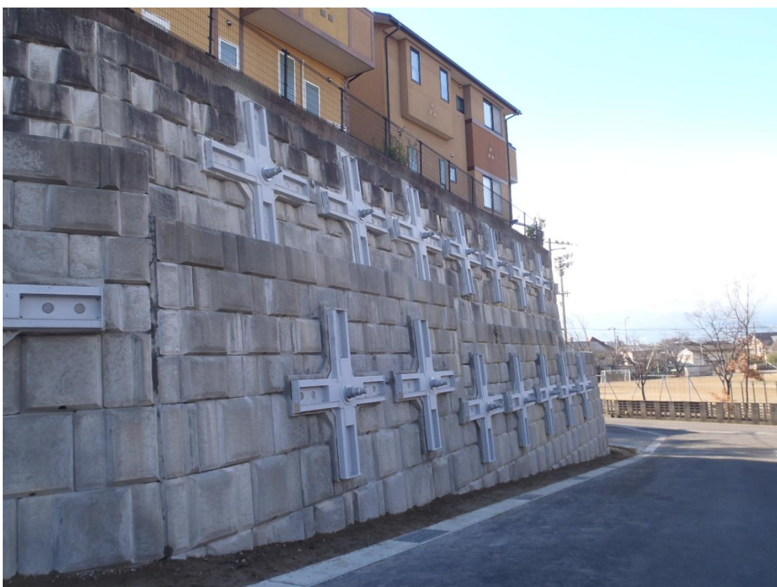
2号擁壁北側竣工
