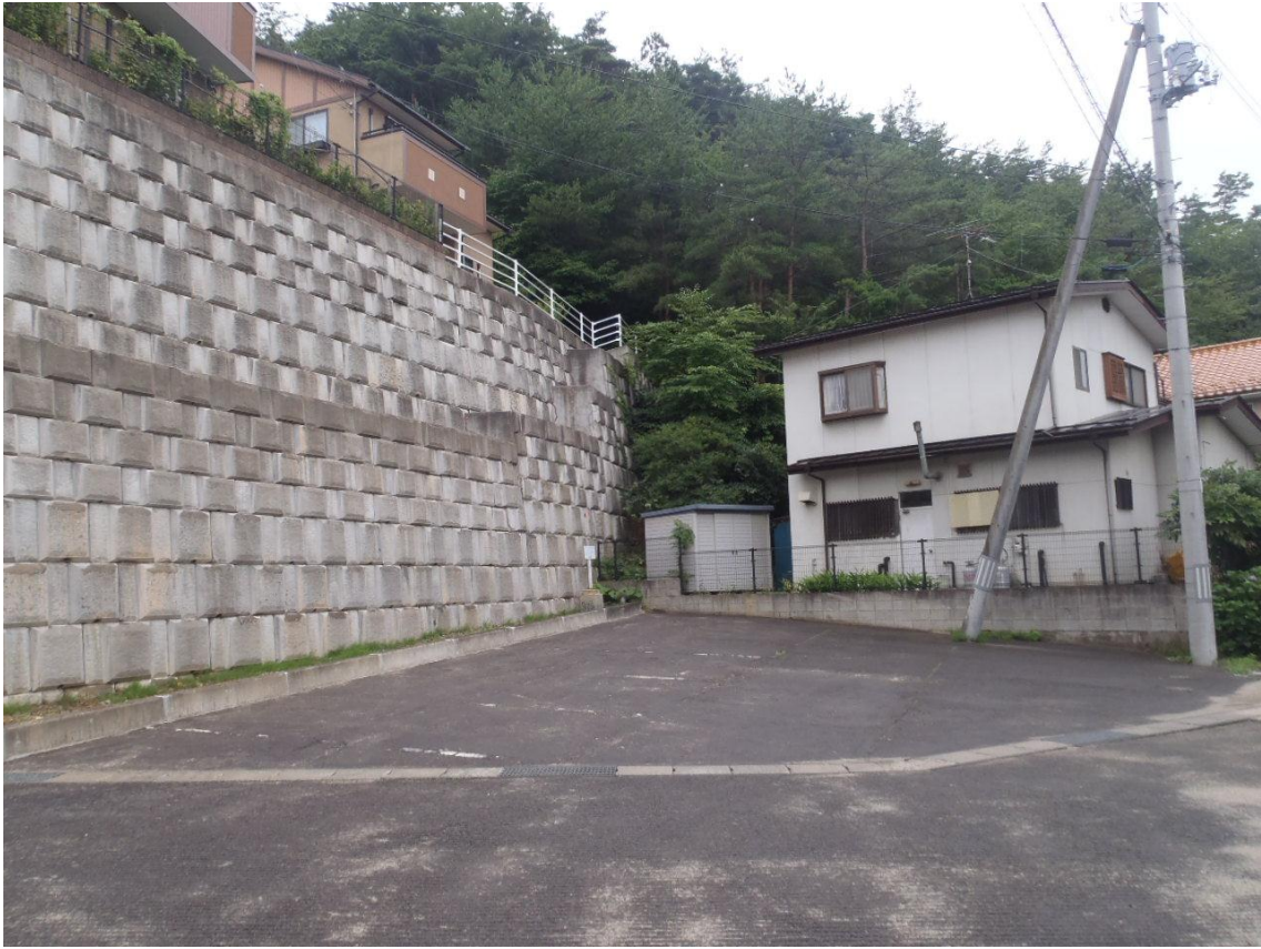
2号擁壁西側施工前
