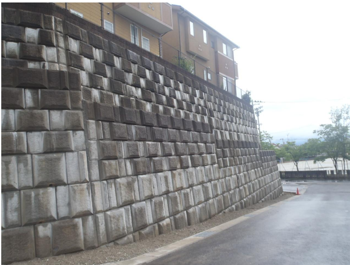
2号擁壁北側施工前
