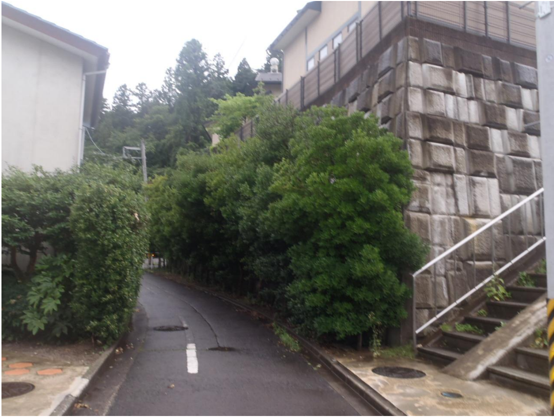
3号擁壁施工前
