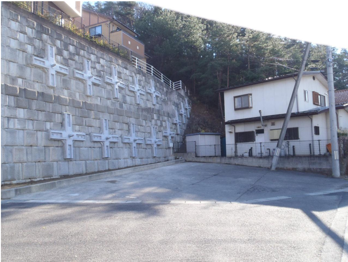
2号擁壁西側竣工
