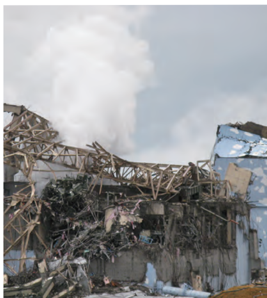
爆発後の福島第一原子力発電所3号機外観 (写真提供：東京電力ホールディングス(株))
