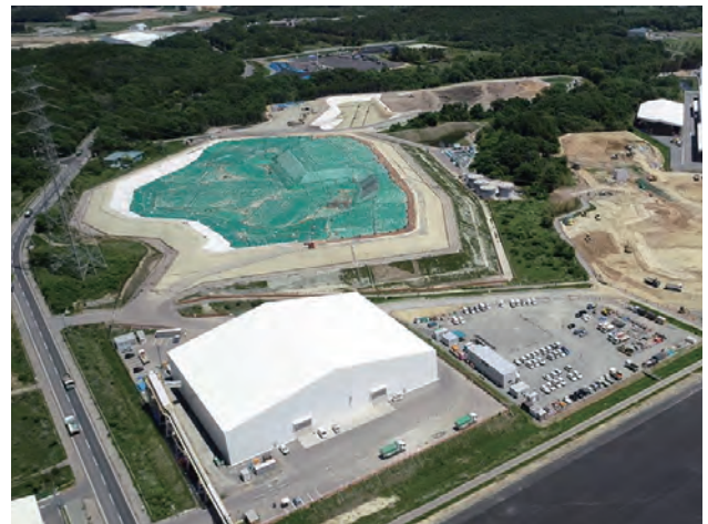
ちゅうかんちょうしせつ ⑥中間貯蔵施設の状況(福島県大熊町・双葉町) (写真提供:福島地方環境事務所)
