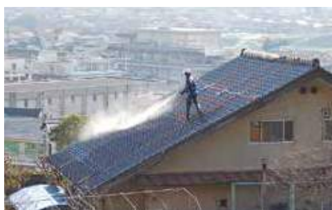
〈参考〉渡利地区住宅の除染作業(屋根洗浄)
