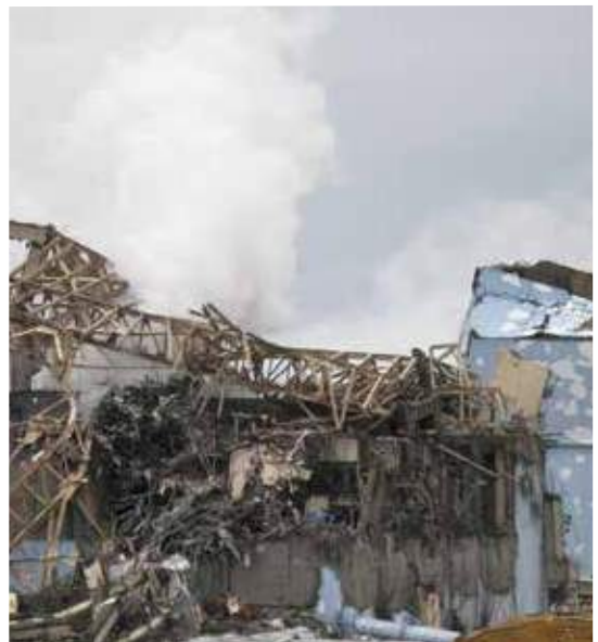
爆発後の福島第一原子力発電所3号機外観 (写真提供:東京電力ホールディングス(株))
