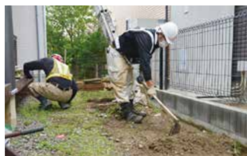
〈参考〉一般住宅の除染作業
