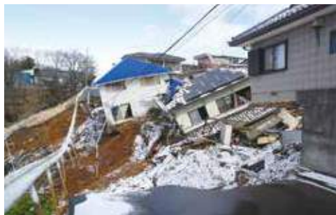
①あさひ台団地の法面崩落
