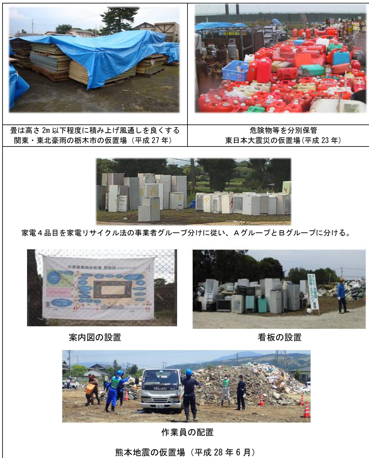
図 5-11 震災時の仮置場における分別保管対策
