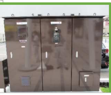
① 分電盤・コンセント盤
