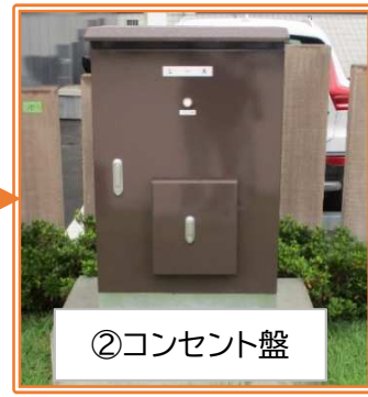
① 分電盤・コンセント盤
