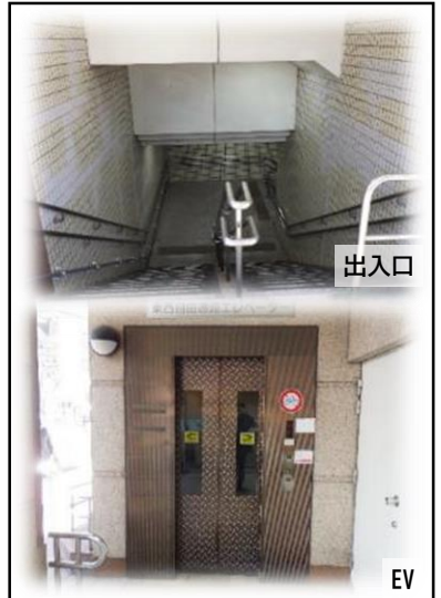
東西自由通路（駅東口側）
