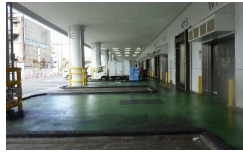
屋根付き荷捌きスペース【京都市】
