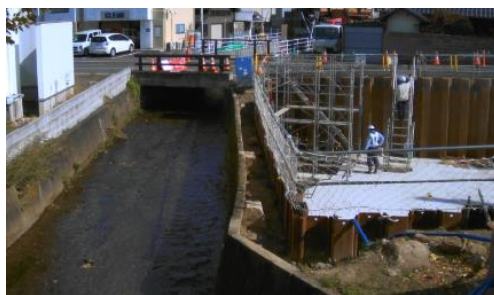
▲ 祇川に整備中の雨水貯留施設
