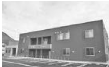
▲中核市への移行に向け、生涯を通じた健康づくり、保健衛生、健康危機管理の拠点となる保健所を整備しました(写真は保健所検査棟)
